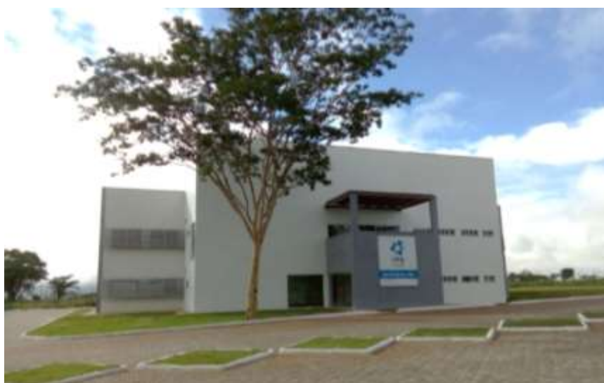
Figura 5. Fachada da Agência de Inovação da UFG localizada no Parque Tecnológico Samambaia
